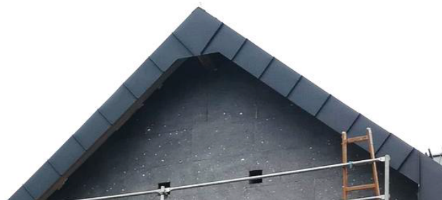
Zdjęcie. Sposób wykończenia blachy na rąbek stojący na wiatrownicy
