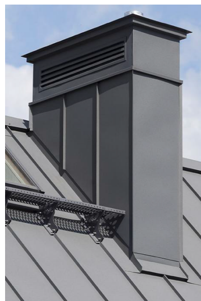
Zdj. Sposób wykończenia i opierzenia kominów
