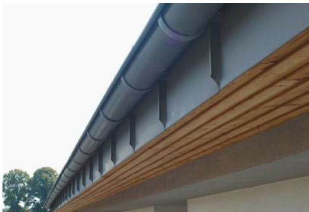
Zdjęcie. Sposób wykończenia blachy w pasie podrynnym na rąbek stojący
